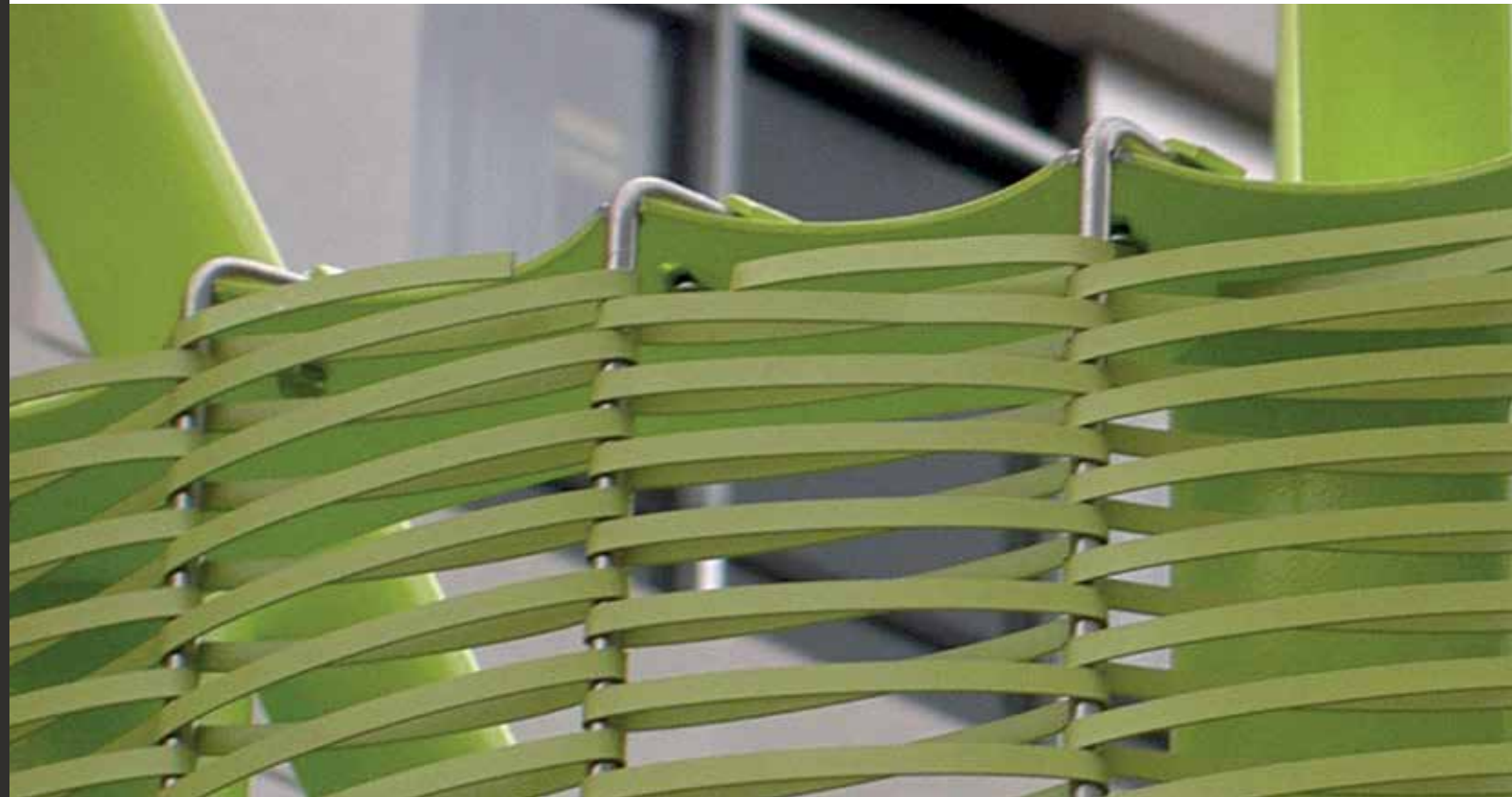
Maille : Escalre 7x1 peinte en vert, projet : système de guidage St. Poelten, architecte : Zieser
